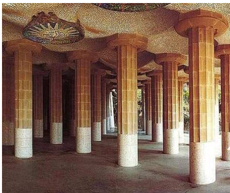
Figura. 9 Columnes transferint les càrregues a terra 11
